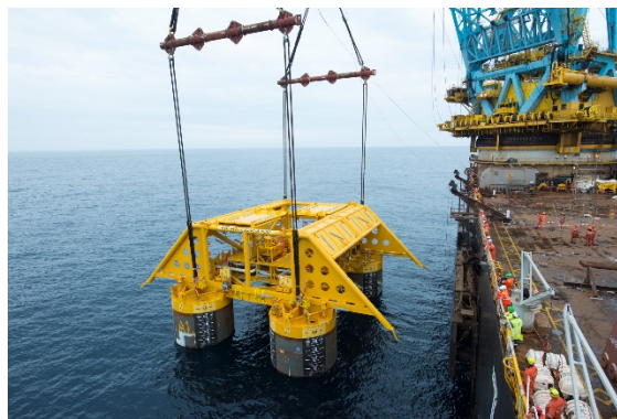
Die Installation der Kompressions-Module im Åsgard-Feld – © Equinor
