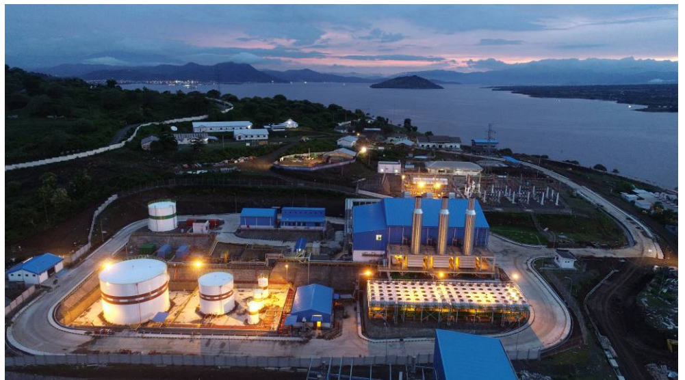
Das neugebaute Kraftwerk in Bima (Foto) stellt 50 MW elektrische Leistung für das Netz der indonesischen Provinz West Nusa Tenggara bereit.
